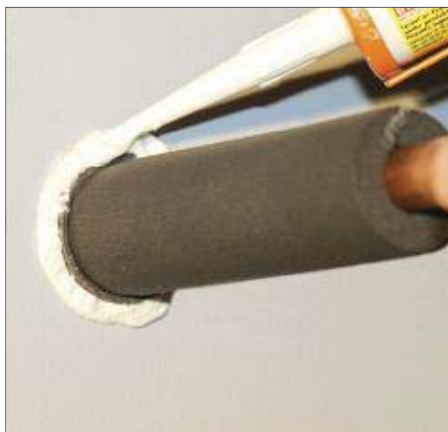
Tett åpningen mellom brannpakningen og utsparringen med Glava Akryl fugemasse eller FS-GPG masse.
