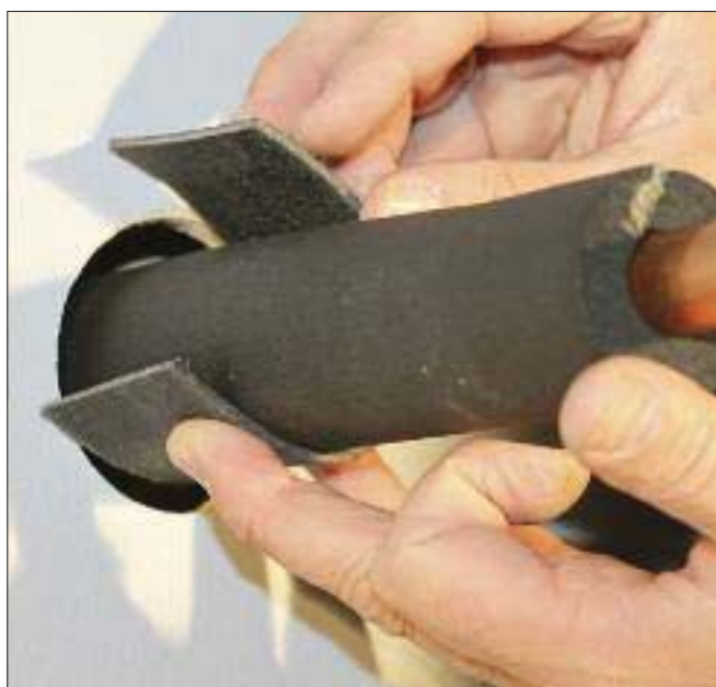
Legg brannpakningen rundt plastrøret eller cellegummiisolasjonen. Fest brannpakningen med elektrostrips/tape og dytt pakningen inn i konstruksjonen.
